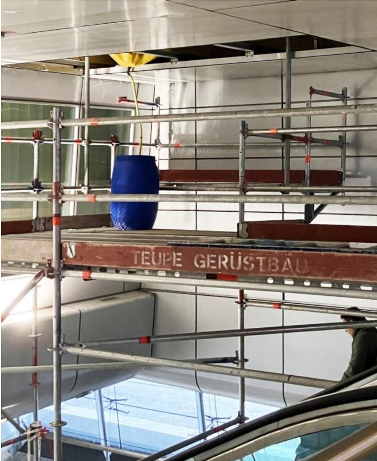
Wunderwerk der deutschen Ingenieurskunst. Ein Gerüst für eine blaue Wassertonne, in die ein gelber Wasserschlauch geht, welcher an einer Plastikplane verschraubt ist und das Regenwasser aus der lecken Decke des Frankfurter Fernbahnhofs an Gleis 6/7 ableitet. Foto: Maria Schneider, 16.10.2024
